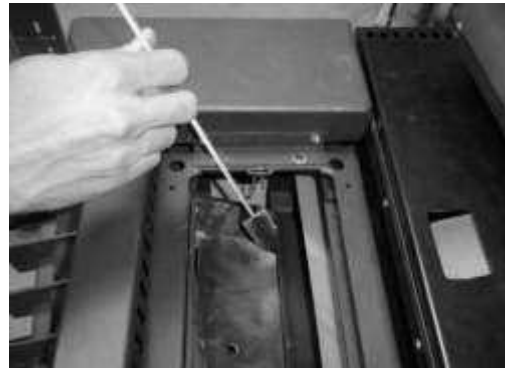
Obrázok 6 – dymové kanáliky pozdĺž spaľovacej komory
